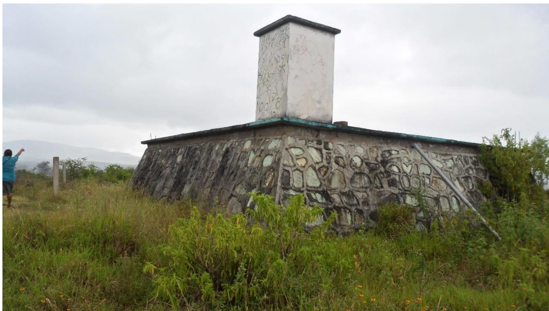
Suministro de agua potable
